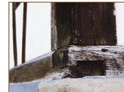
Assemblage au niveau du poteau cornier
