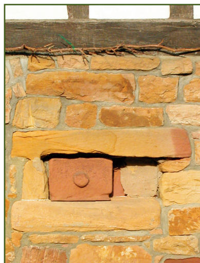
Ouvertures créées dans les soubassements pour l'aération des caves. La fermeture est en grès et coulisse horizontalement.
