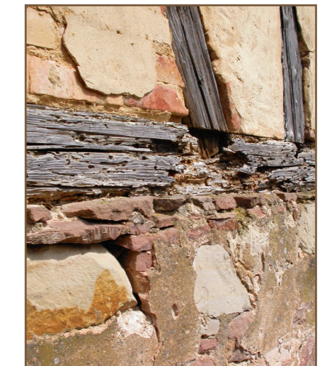
Forte dégradation de la sablière
